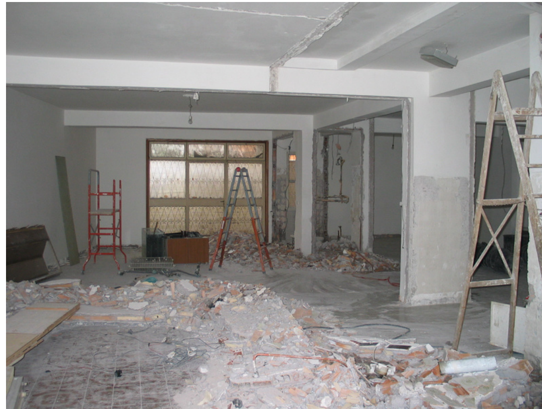
fase di demolizione
