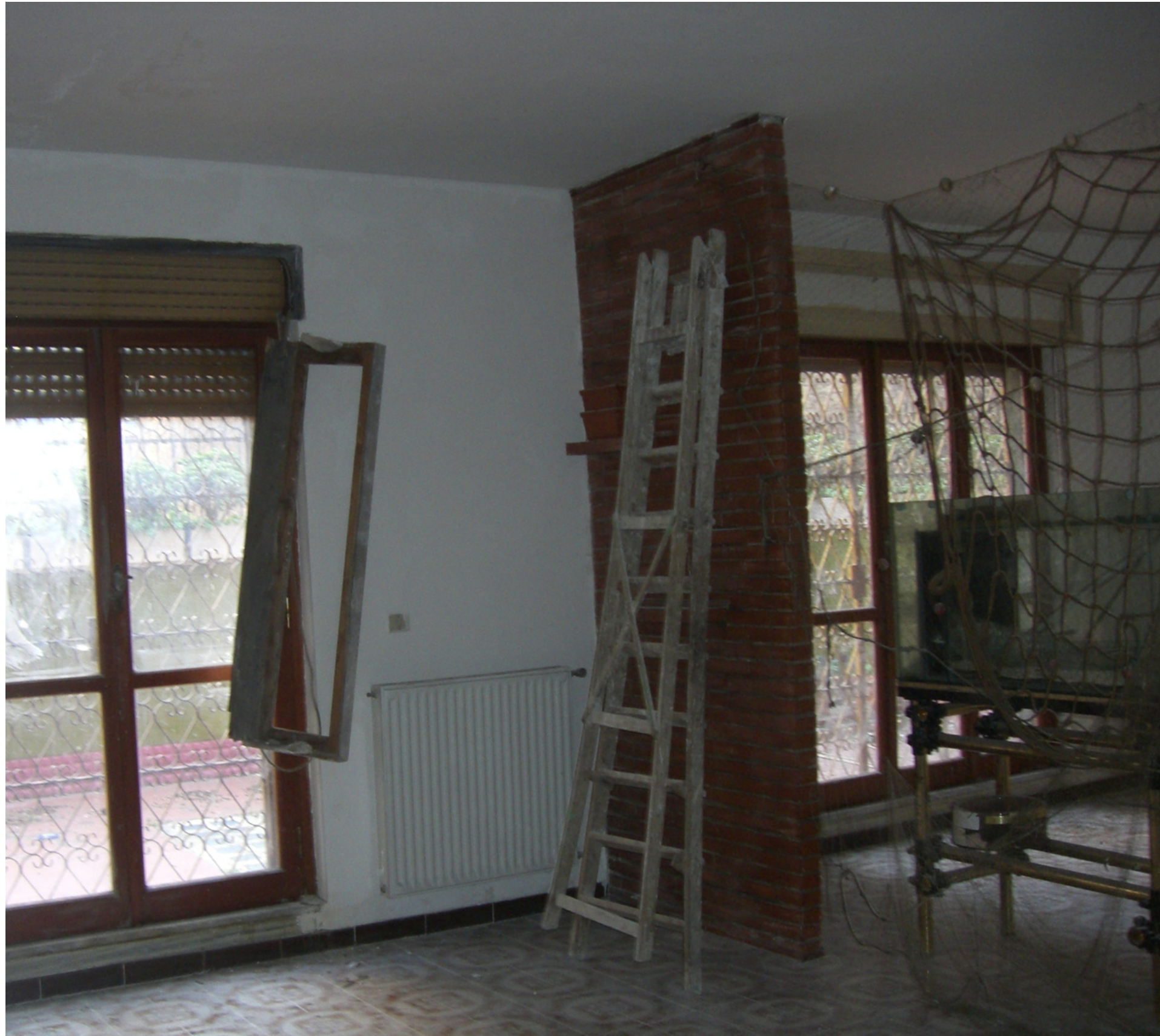
prima dei lavori
