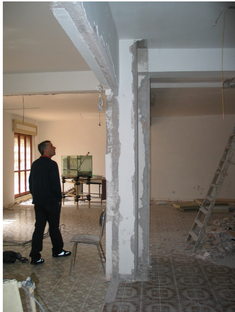
fase di demolizione
