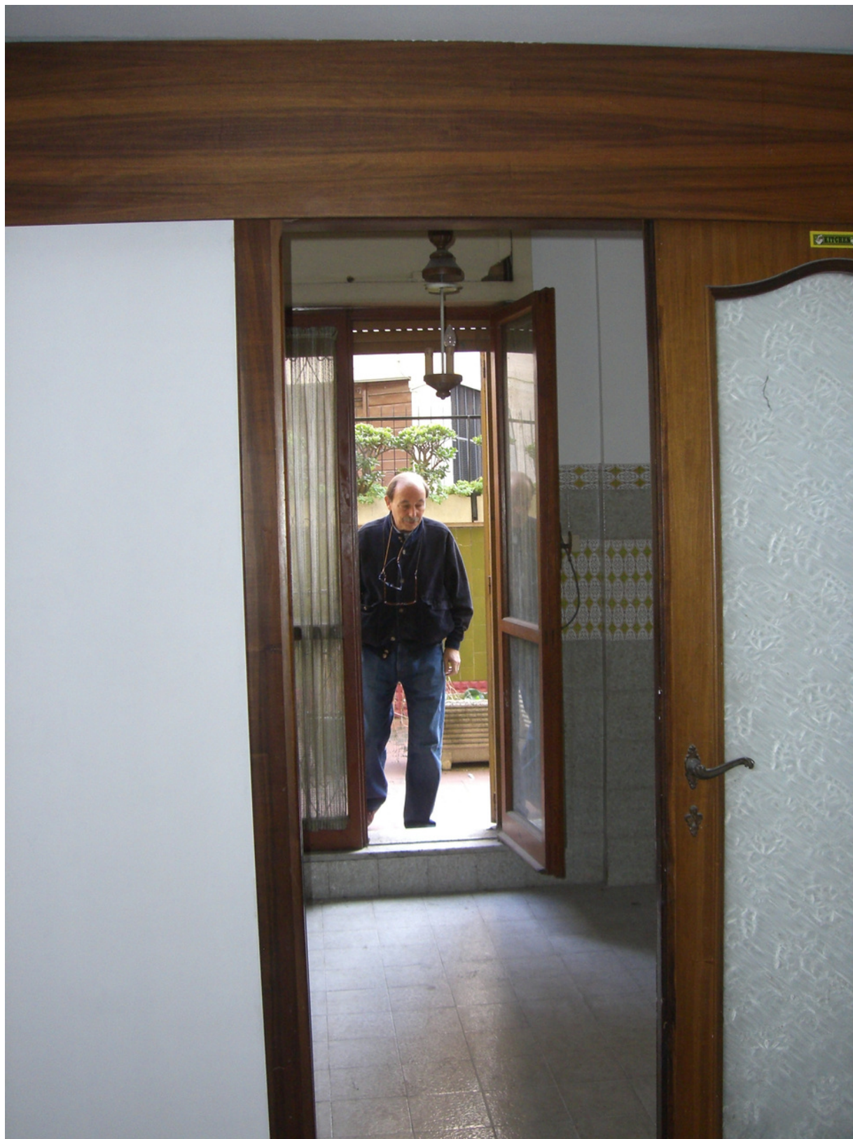
prima dei lavori
