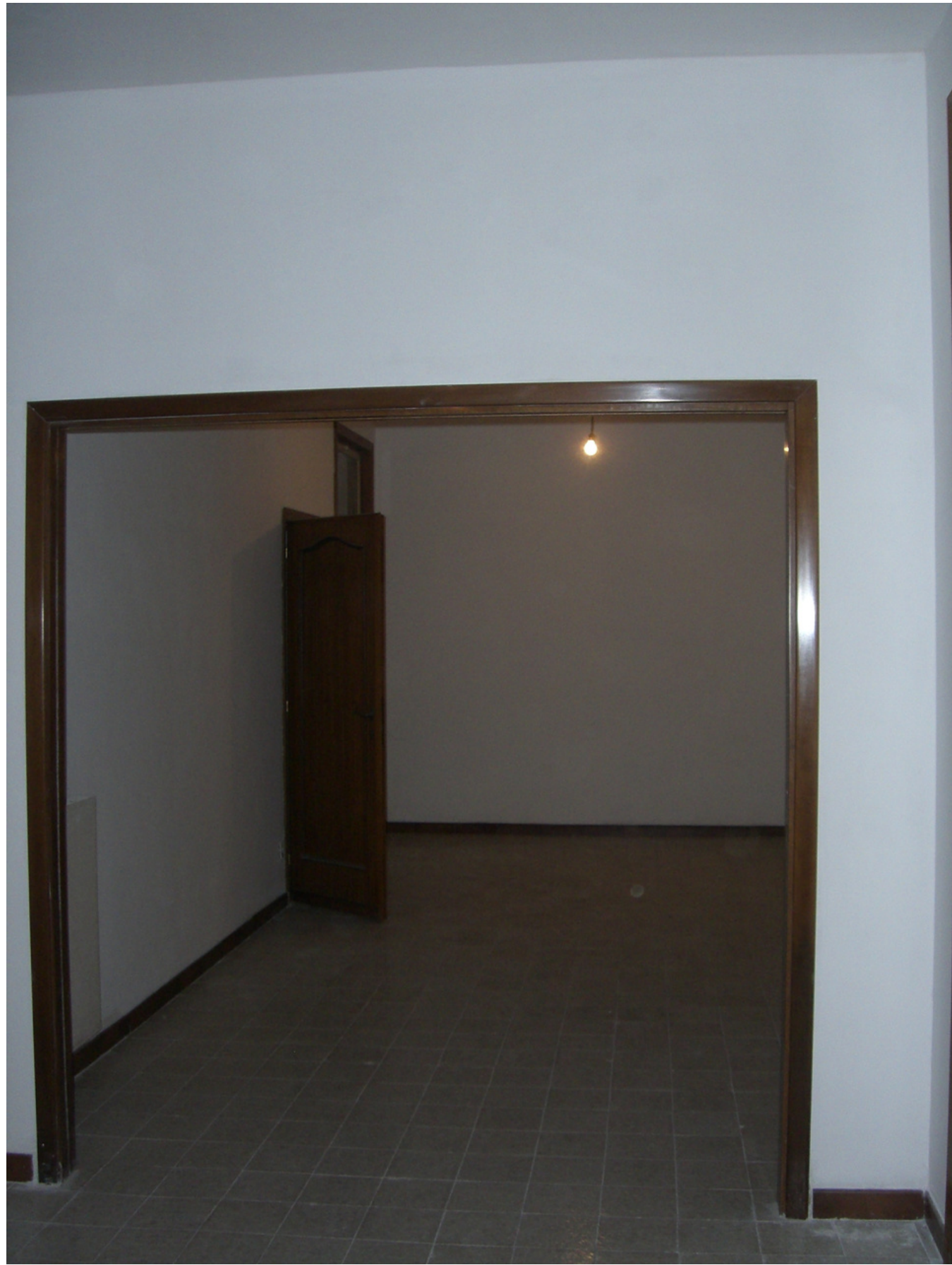
prima dei lavori
