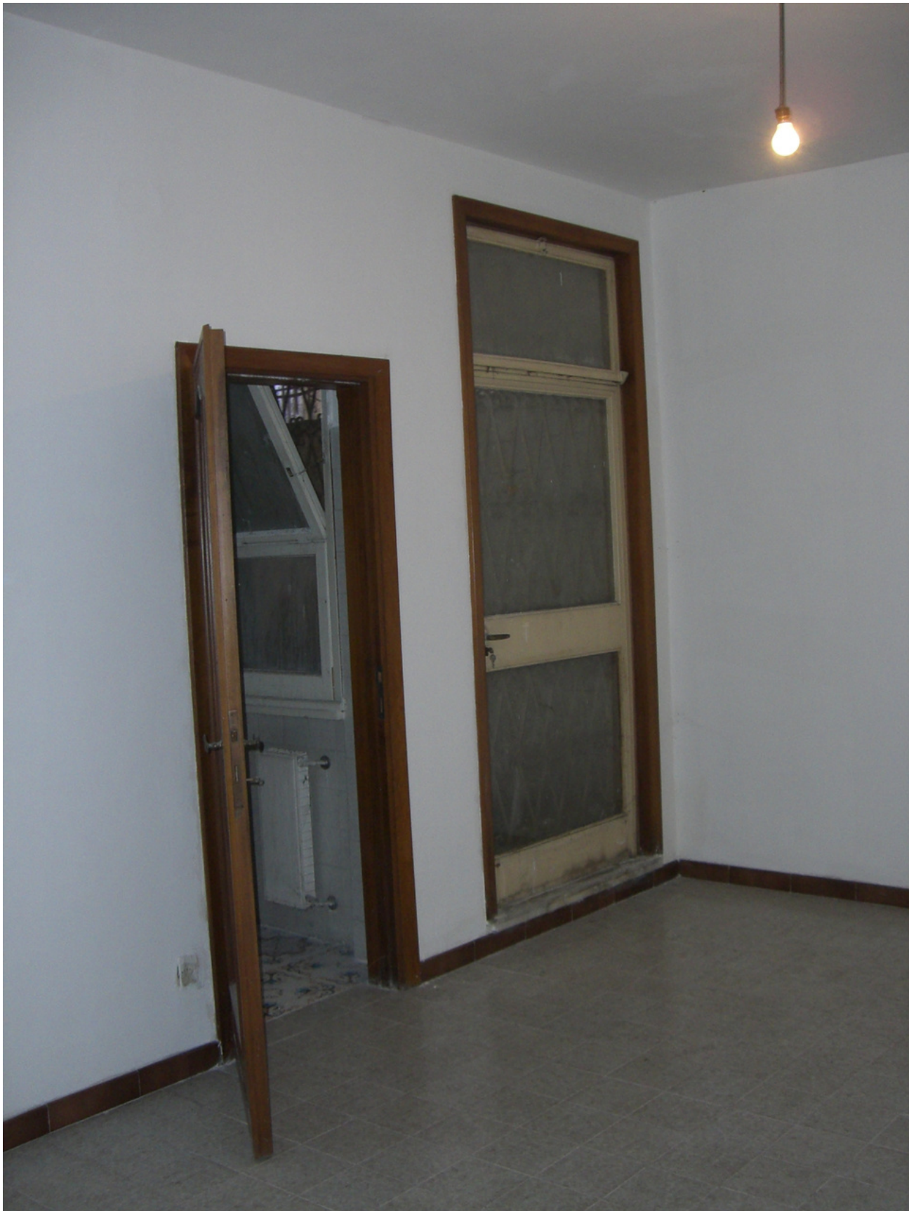
prima dei lavori
