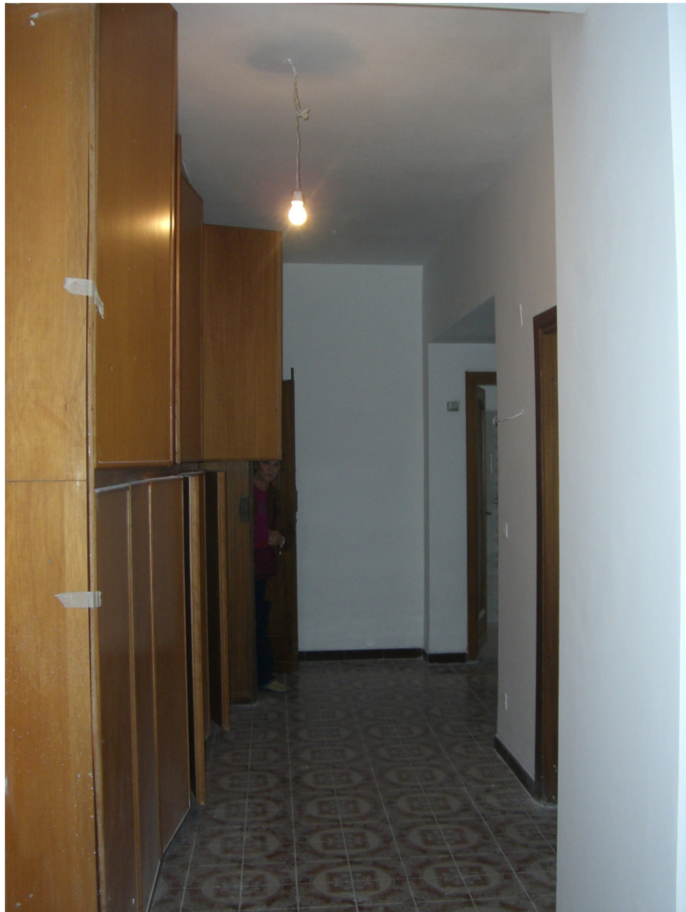
prima dei lavori
